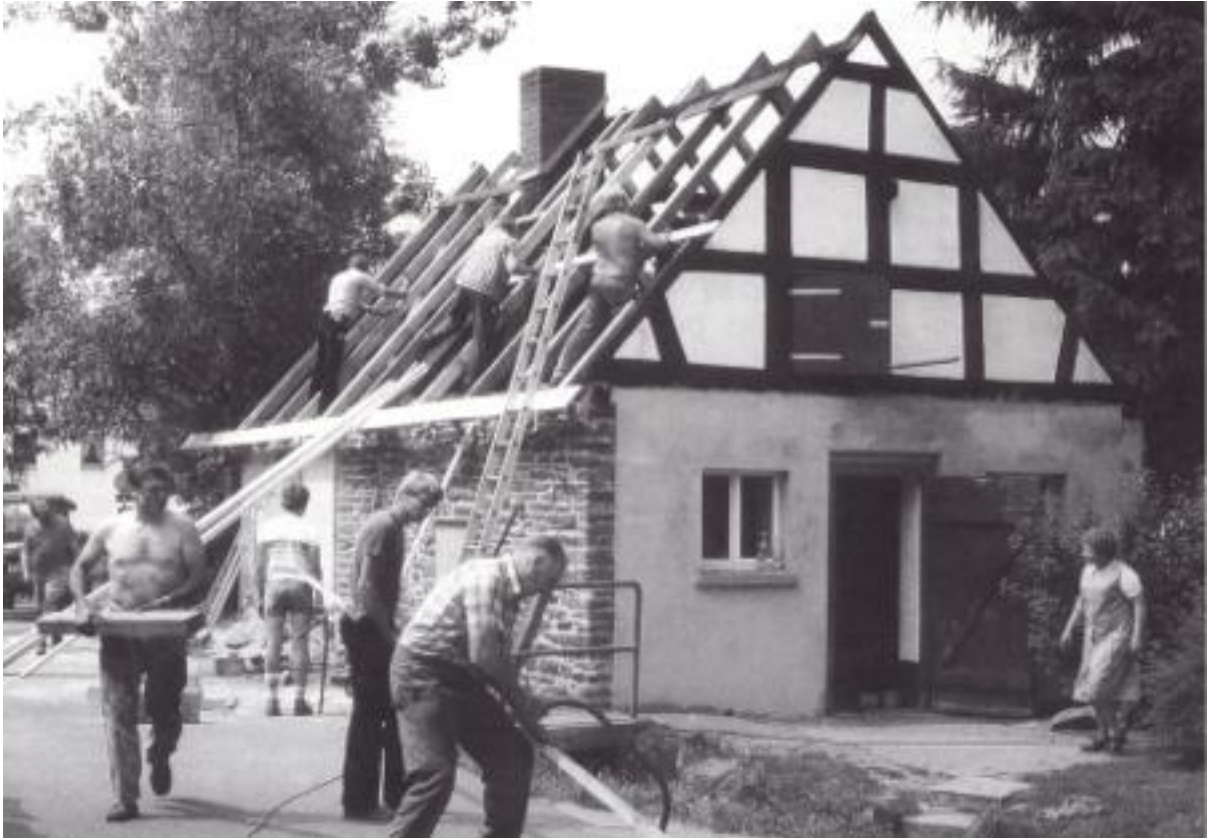
Erneuerung des Daches beim Backhaus der Genossenschaft im Oberdorf (um 1980). Die ganze Nachbarschaft ist im Einsatz.
